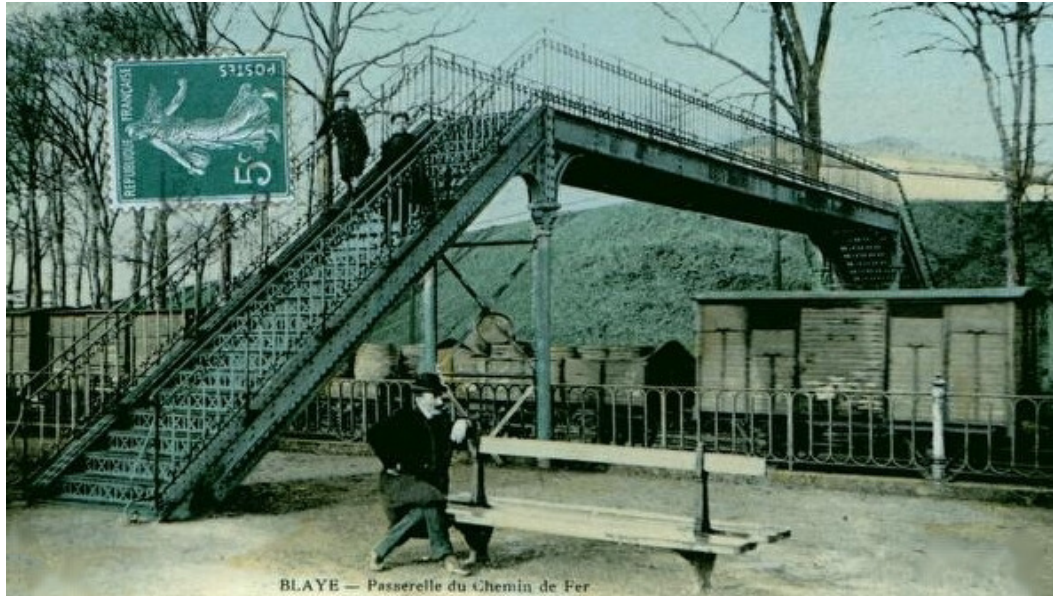
Passerelle du chemin de Fer, Blaye.
