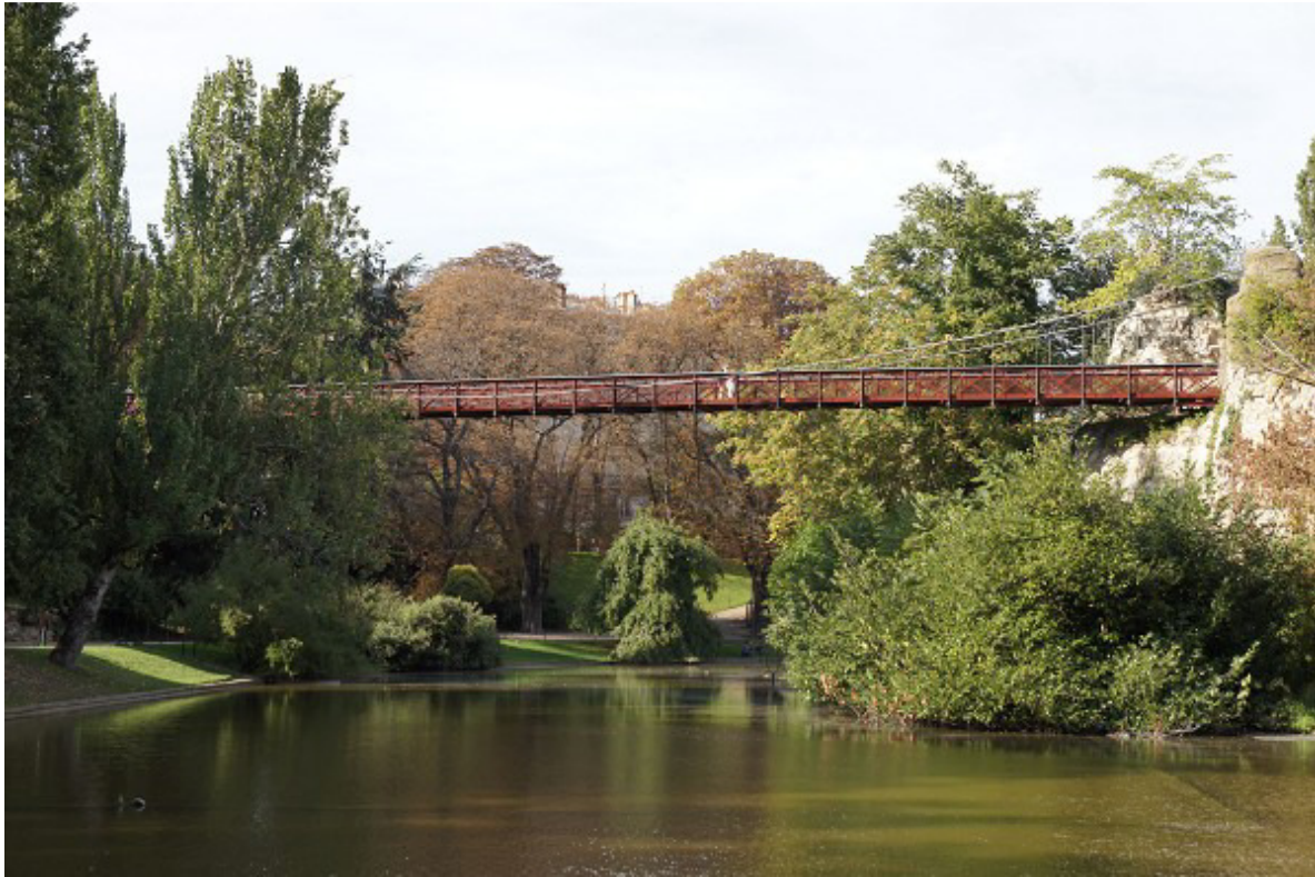
Passerelle dans le Parc des Buttes-Chaumont, Paris
