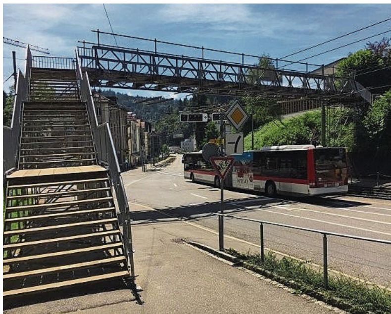
Passerelle, Teufenerstraße, St. Gallen-Riethüsli.
